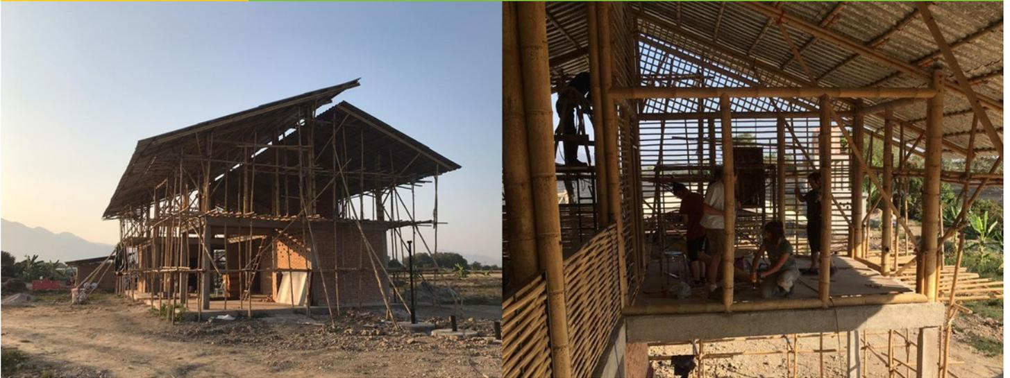
Nachdem das Dach gebaut wurde (links), ging es weiter mit den Bambusgerüsten für die späteren Lehmwände (rechts).
